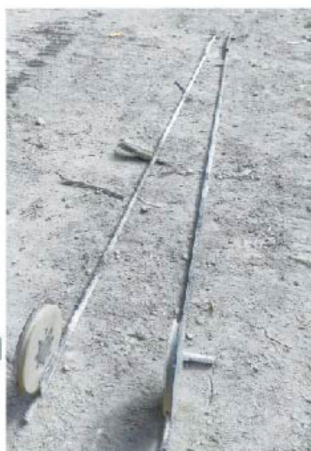
用金刚石绳锯借助导向轮切割后背切缝
